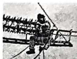
工人穿戴工作服进行超高压带电作业
